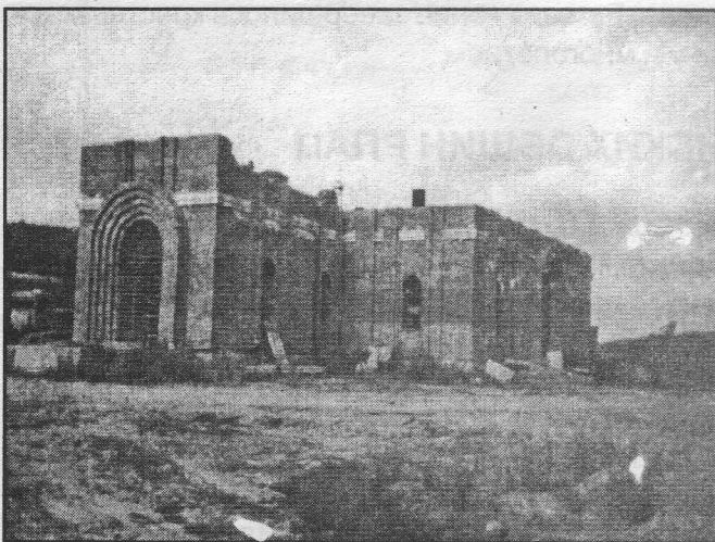
Строящийся двухэтажный храм в г. Златоуст
