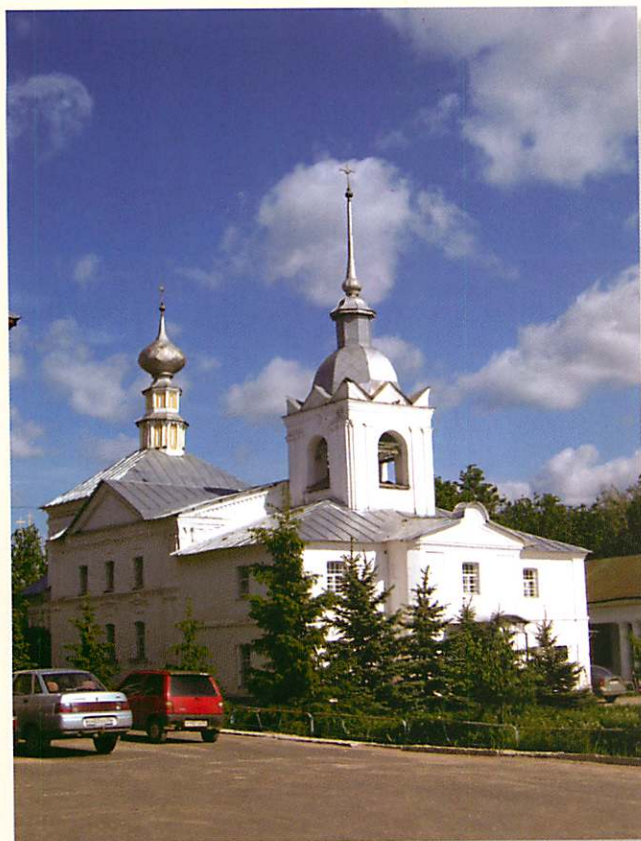
Кресто-Никольская церковь (1770 г.). Передана РПАЦ в 1992 г. Реставрация завершена в 1993 г.
