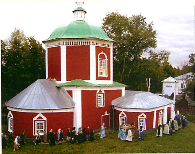
Успенская церковь (к. XVII-XVIII вв.). Передана Суздальской Епархии РПАЦ в 1996 г. Реставрационные работы завершены в 1998 г. Восстановлена купольная и стенная роспись начала XX века
